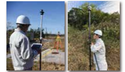
TSにて補備測量
